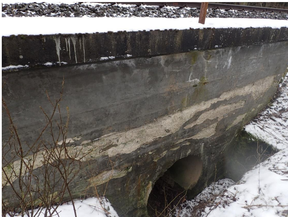
Foto 4: Beton pravého čela propustku silně zdegradovaný
