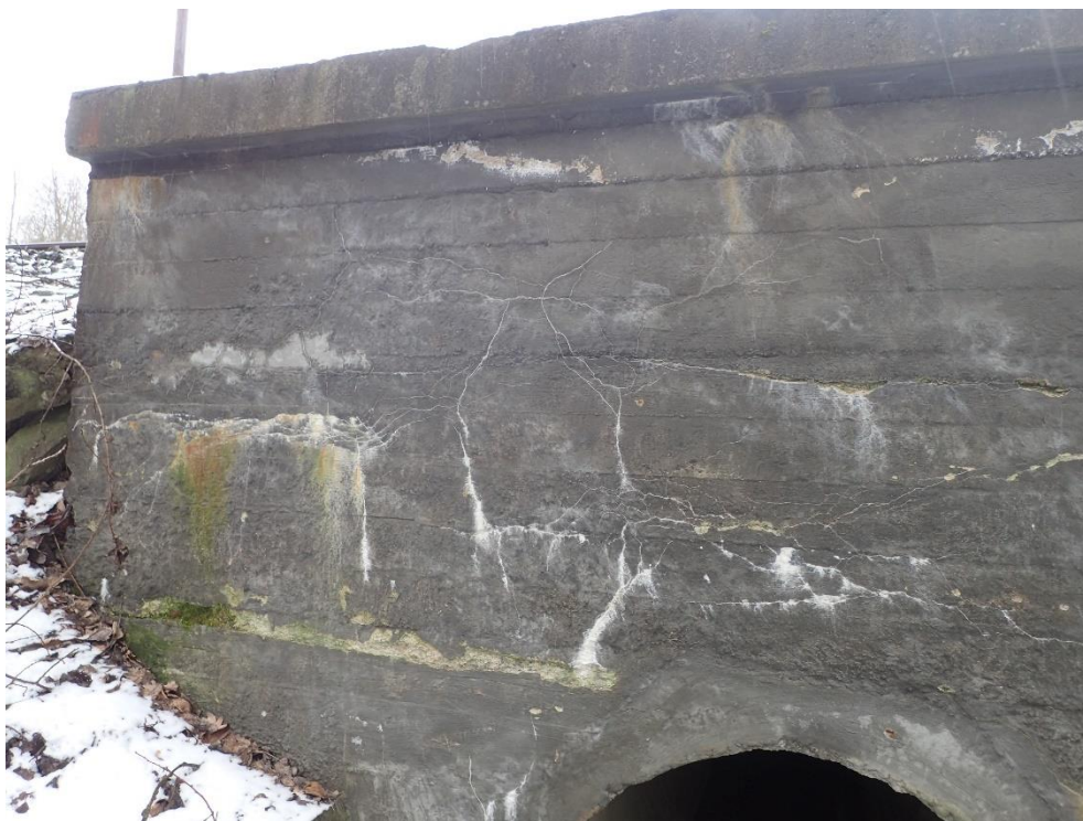
Foto 3: Levé čelo propustku popraskané, se záteky a výluhy
