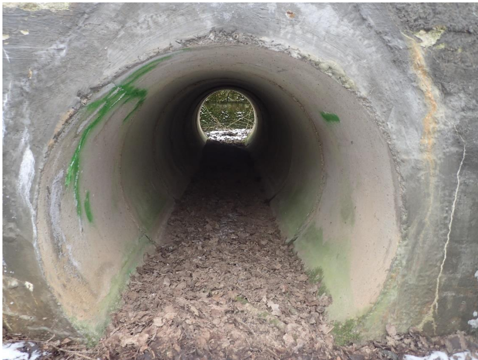
Foto 5: Degradace betonu, jednotlivé trouby různě pokleslé
