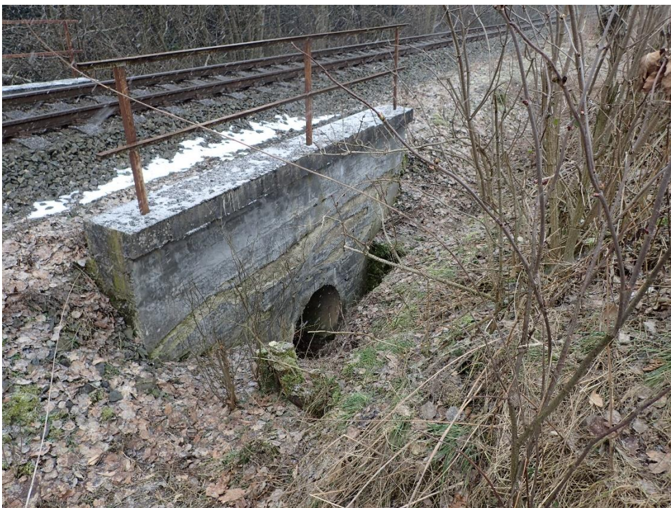
Foto 2: Pohled na vtok propustku
